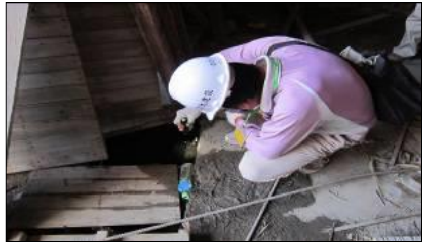
車道下方水溝
