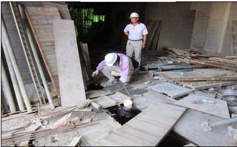
車道下方水溝
