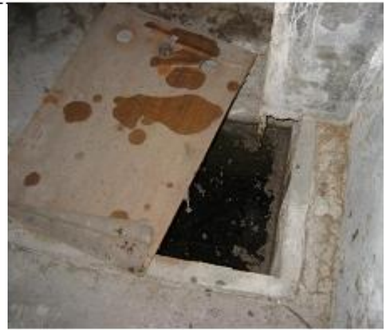
地下室污水池
