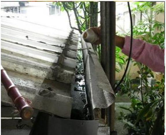
天溝(屋簷排水槽)
