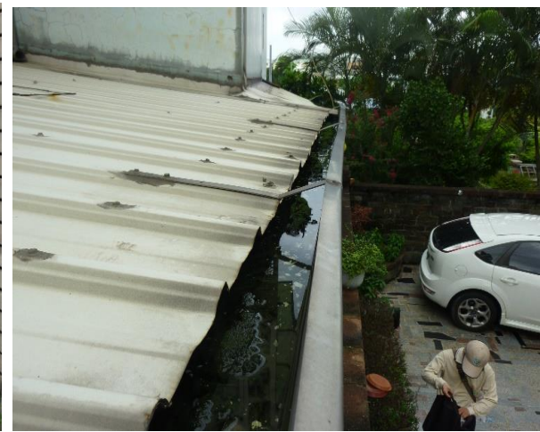
天溝(屋簷排水槽)
